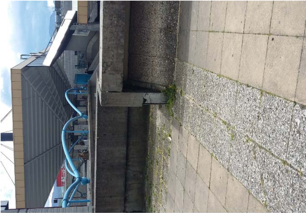
Exemple de protection en partie courante et de relevé non entretenus, fissurés, dans lequel la végétation pousse et ou l'eau s'infiltré
