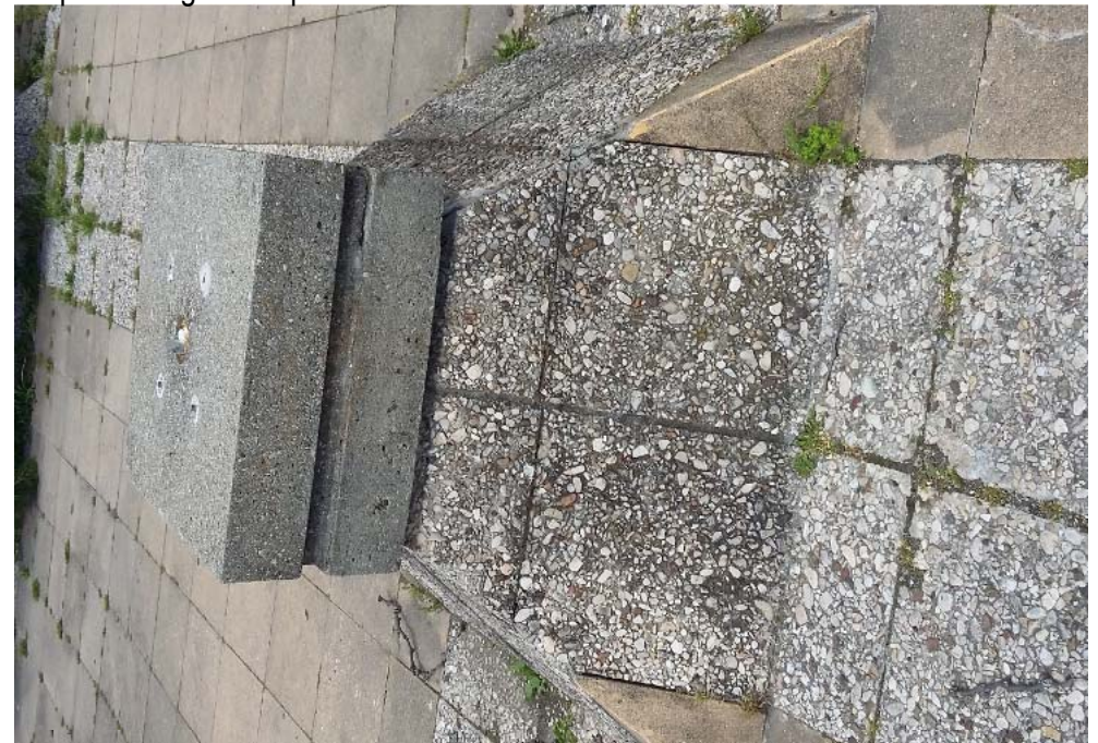
Exemple de protection en partie courante et de relevé non entretenus, fissurés, dans lequel la végétation pousse et ou l'eau s'infiltré
