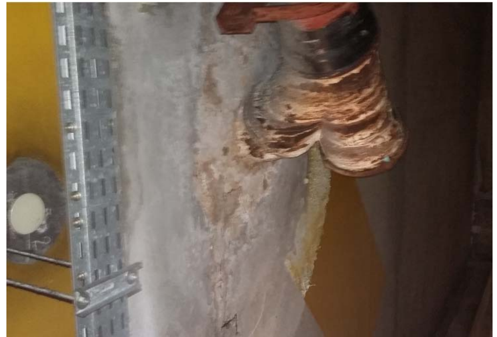
Constats des traces des infiltrations en plafond visibles au droit d'une pénétration d'eau pluviales d'un regard extérieur non entretenu
