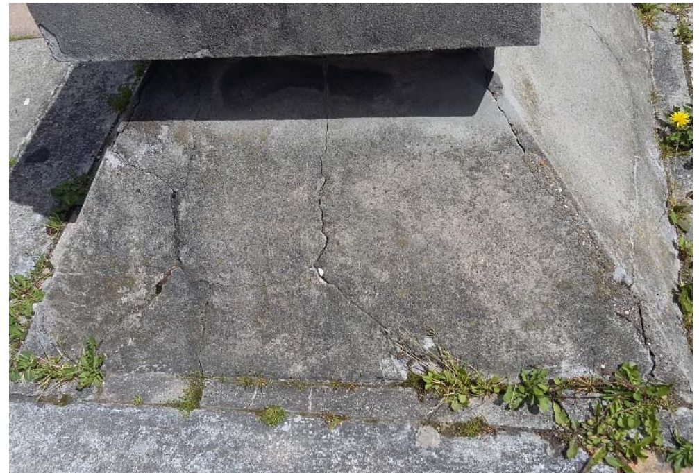
Exemple regard eaux pluviales non entretenu et de protection en partie courante de nature différente, manquantes par endroits et de relevés non entretenus, fissurés, dans lequel la végétation pousse et ou l'eau s'infiltre
