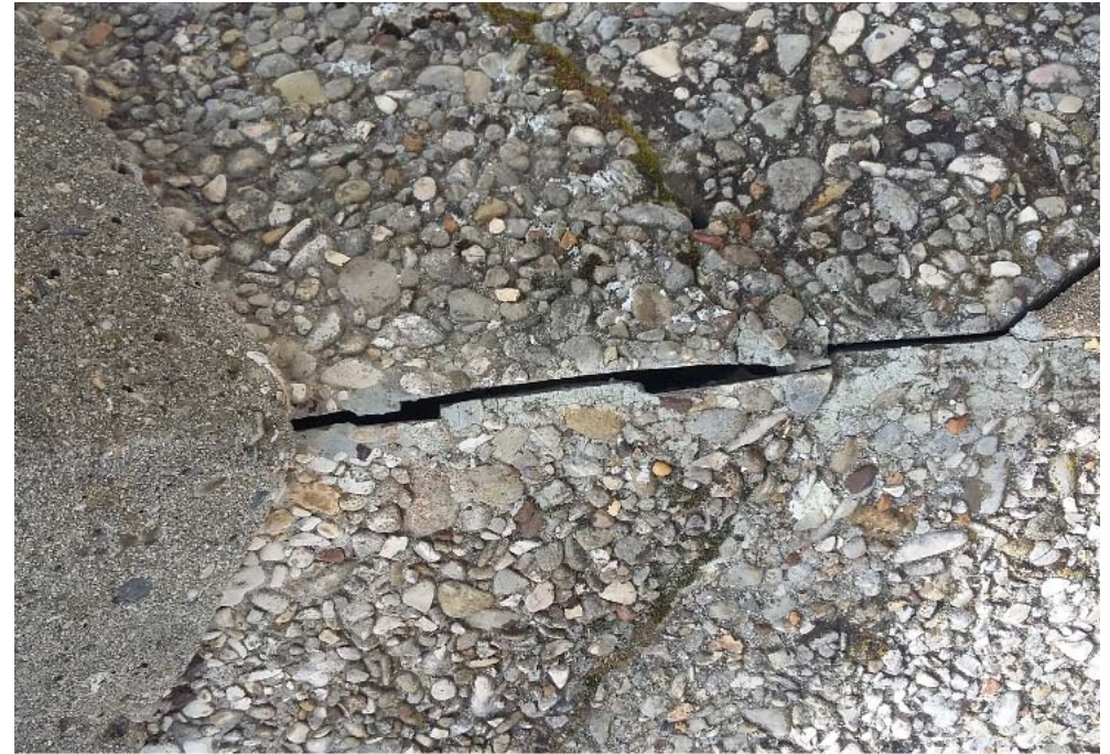
Exemple de protection en partie courante et de relevé non entretenus, fissurés, dans lequel la végétation pousse et ou l'eau s'infiltré
