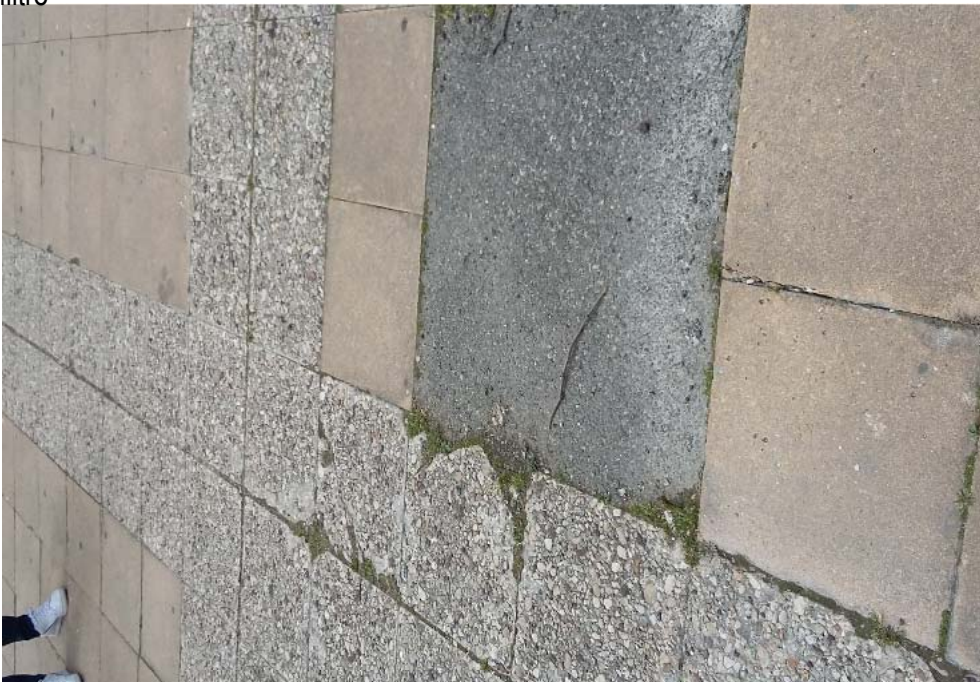
Exemple regard eaux pluviales non entretenu et de protection en partie courante de nature différente, manquantes par endroits et de relevés non entretenus, fissurés, dans lequel la végétation pousse et ou l'eau s'infiltre
