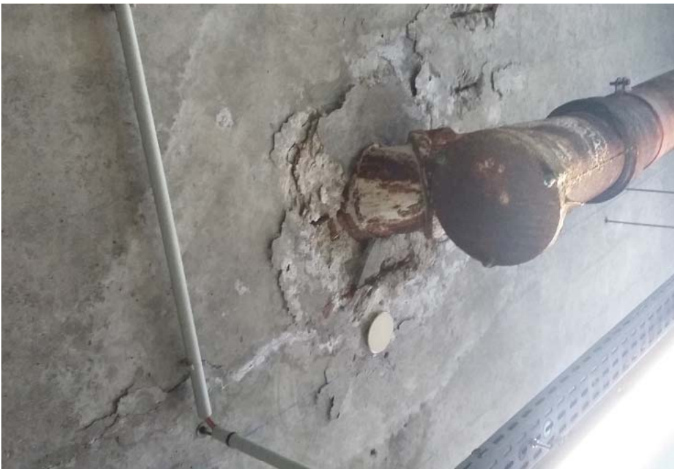
Constats des désordres suite aux infiltrations en plafond visibles au droit d'une pénétration d'eau pluviales d'un regard extérieur non entretenu
