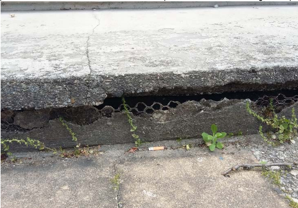
Exemple de relevé non entretenu, fissurés dans lesquels l'eau s'infiltre, et la végétation pousse
