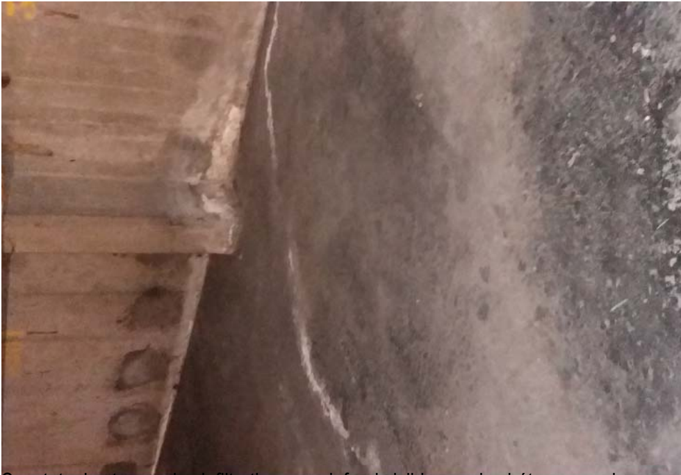
Constats des traces des infiltrations en plafond visibles sur les bétons en sol
