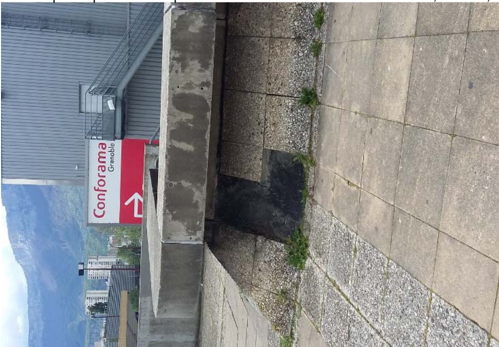
Exemple de protection en partie courante et de relevé non entretenus, fissurés, dans lequel la végétation pousse et ou l'eau s'infiltré
