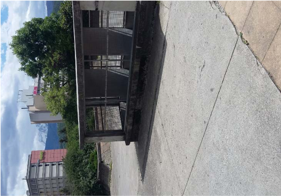
Exemple de protection en partie courante de nature différente et de relevés non entretenus, fissurés, dans lequel la végétation pousse et ou l'eau s'infiltr
