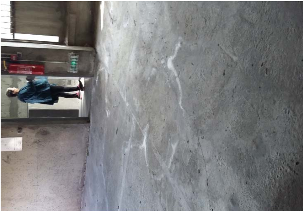
Constats des traces des infiltrations au sol visibles au droit d'une façade non fermée
