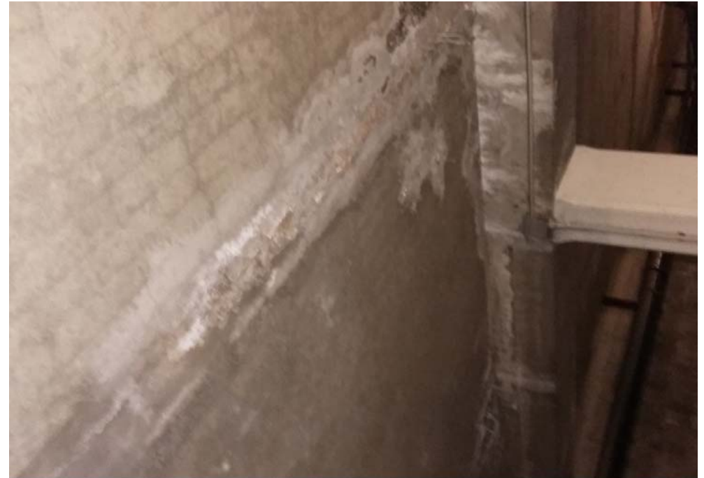
Constats des traces des infiltrations en plafond visibles au droit d'un joint de dilatation
