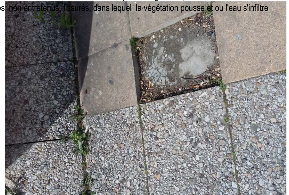
Exemple regard eaux opluviales non entretenu et de protection en partie courante de nature différente, manquantes par endroits et de relevés non entretenus, fissurés, dans lequel la végétation pousse et ou l'eau s'infiltr
