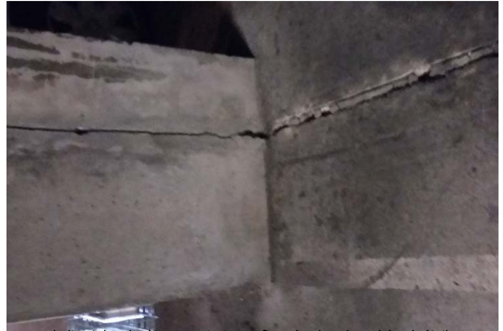
Exemple protection en relevés et partie courante de nature différente, manquantes par endroits et de relevés non entretenus, fissurés, dans lequel la végétation pousse et ou l'eau s'infiltre
