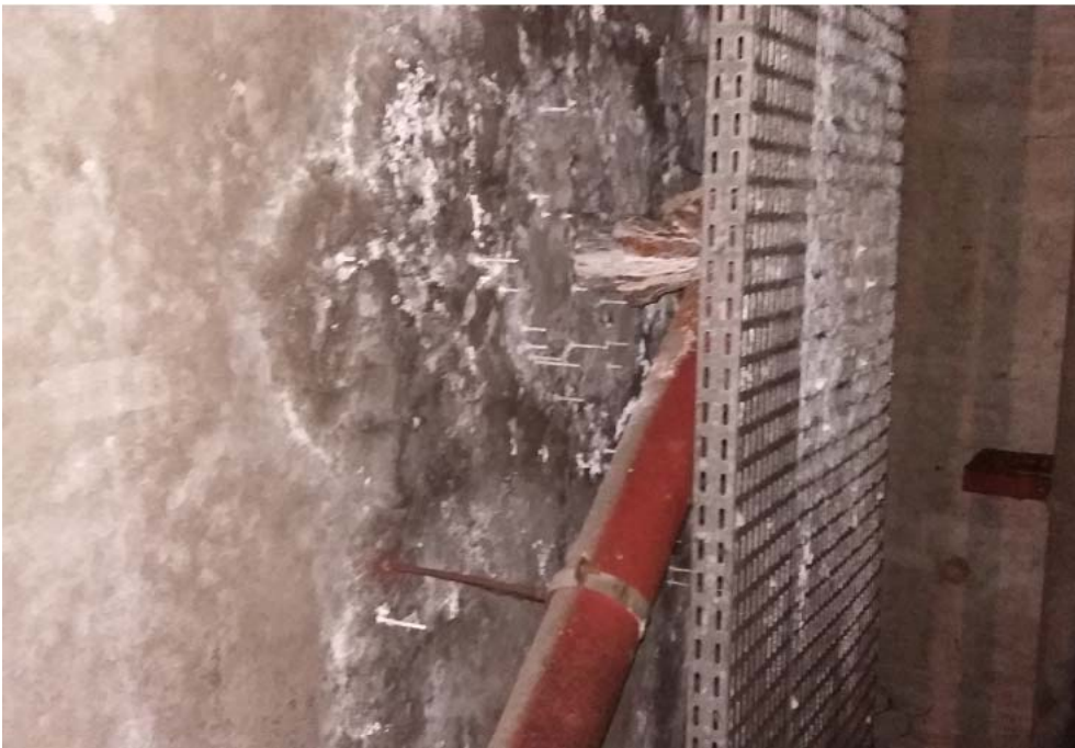
Constats des traces des infiltrations en plafond visibles stalagmites de calcite
