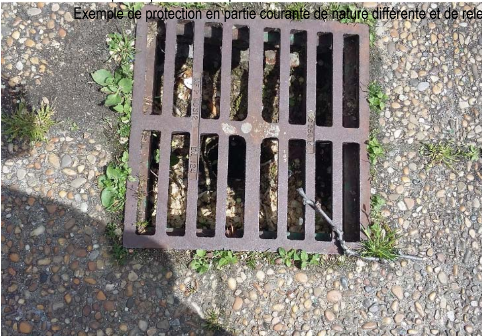
Exemple regard eaux opluviales non entretenu et de protection en partie courante de nature différente, manquantes par endroits et de relevés non entretenus, fissurés, dans lequel la végétation pousse et ou l'eau s'infiltr
