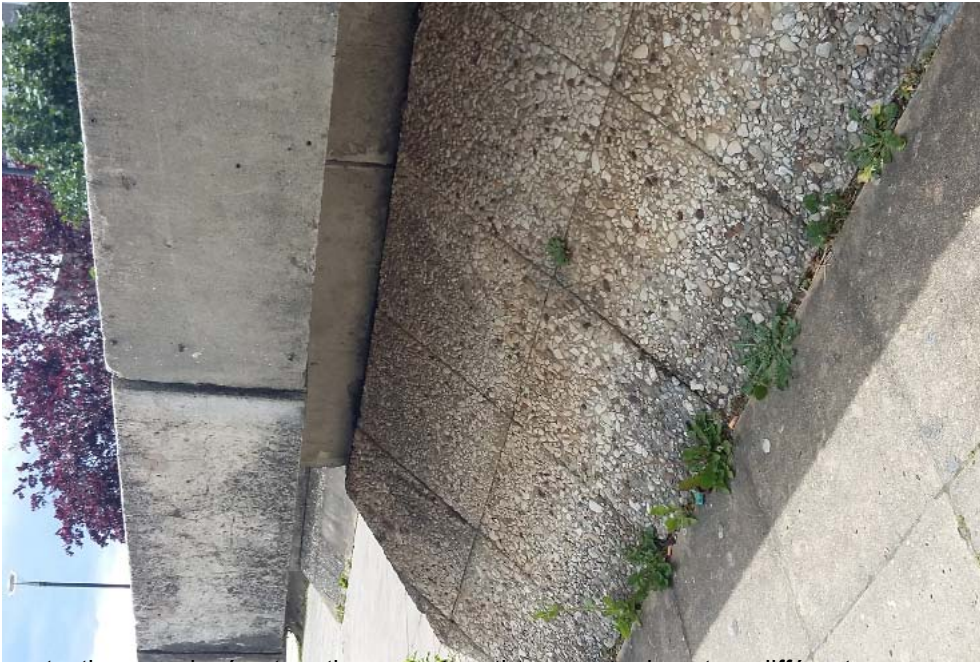
Exemple protection en relevés et partie courante de nature différente, manquantes par endroits et de relevés non entretenus, fissurés, dans lequel la végétation pousse et ou l'eau s'infiltre
