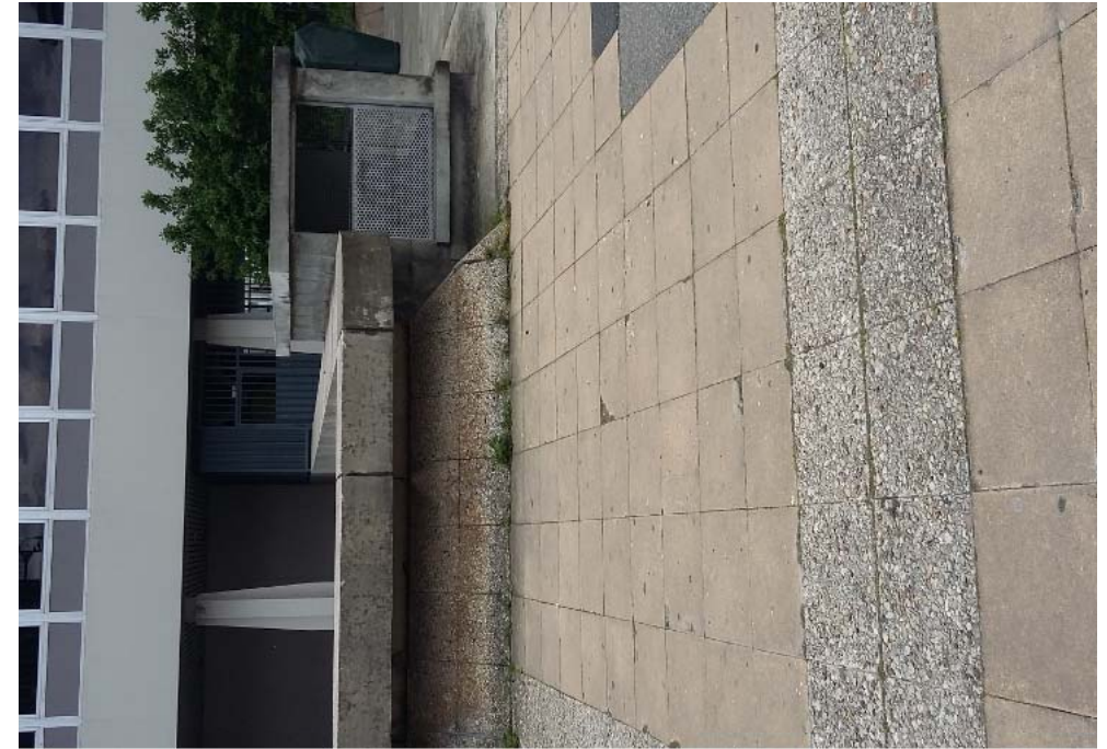
Exemple de protection en partie courante de nature différente et de relevés non entretenus, fissurés, dans lequel la végétation pousse et ou l'eau s'infiltr
